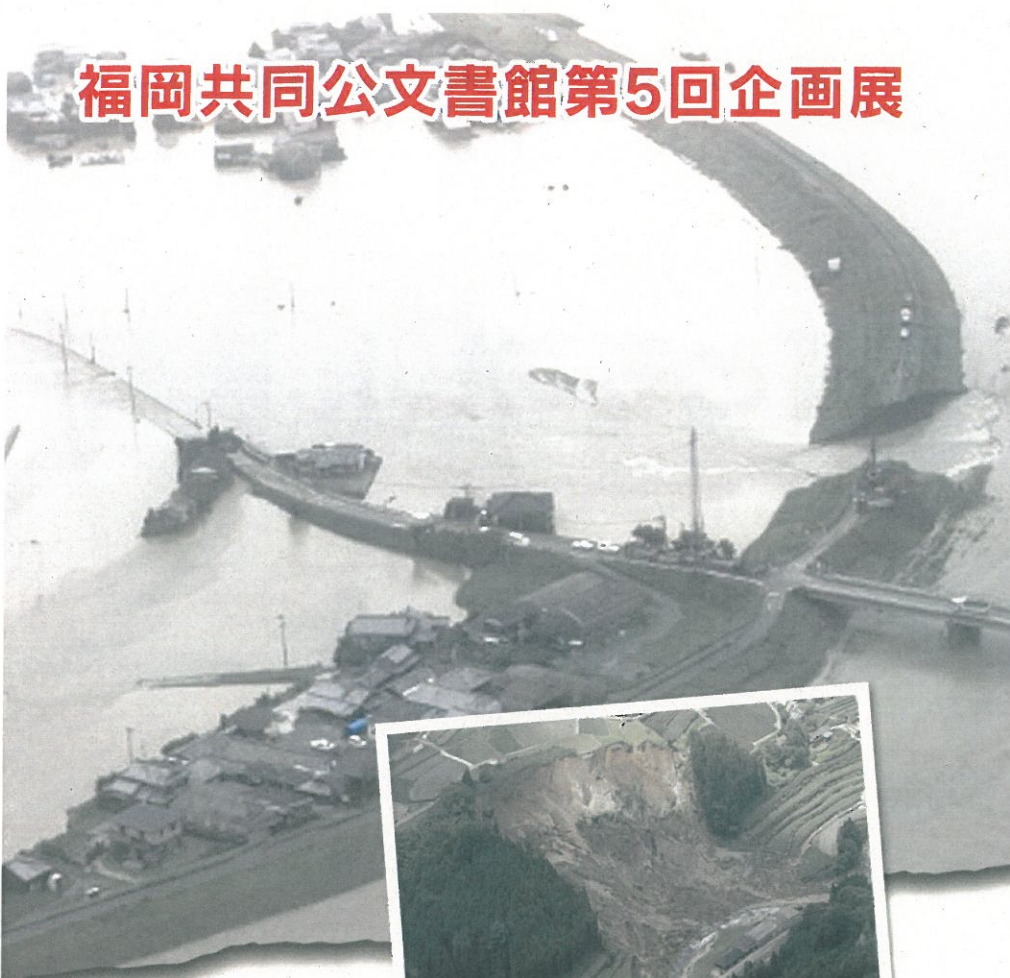
矢部川(柳川市大和町) 『平成24年7月梅雨前線豪雨の災害記録』 (福岡県土整備部)
